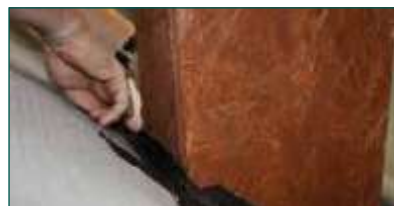
8. Монтаж ленты у верхней горизонтальной плоскости
