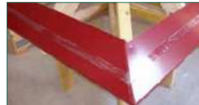
10. Клеїти стрічку на крапельник по периметру звису
