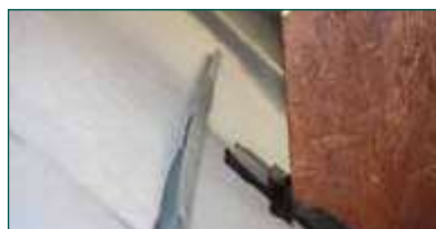
13. Герметизировать все стыки и примыкания бутилкаучуковой лентой
