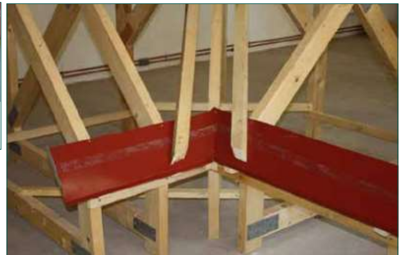
14. Готовий конструктив в розжолобку
