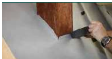
4. Начать герметизацию примыканий бутилкаучуковой лентой
