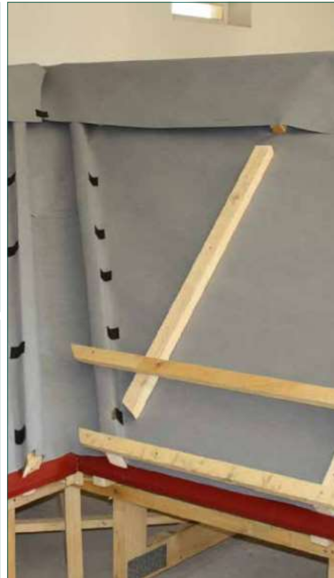
5. Готовая конструкция вентилируемого конька
