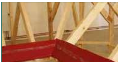
11. Почати монтаж решетування в розжолобку
