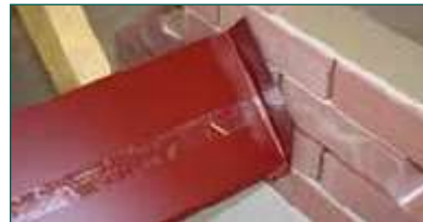
6. Загнути крапельник в місці примикання до несучої стіни
