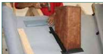
11. Начать монтаж водоотводящей планки
