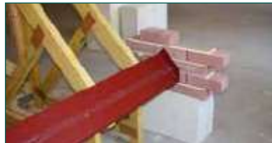
5. Монтувати стрічку до кінця крапельника
