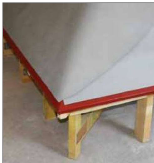
6. Монтувати мембрану з іншого боку внахлест
