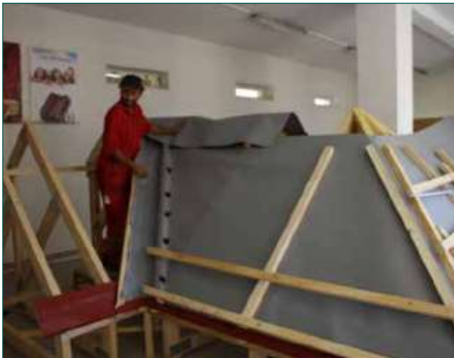
2. Вырезать часть мембраны так, чтобы обеспечить перехлест через конек
