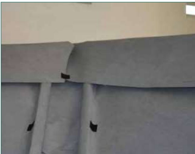
4. Соединить места нахлестов бутилкаучуковой лентой
