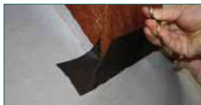
5. Монтаж ленты на углах
