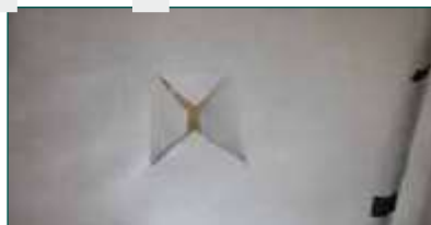
1. Вырезать мембрану под печную трубу
