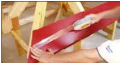
4. Стрічку приклеїти в середній частині крапельника
