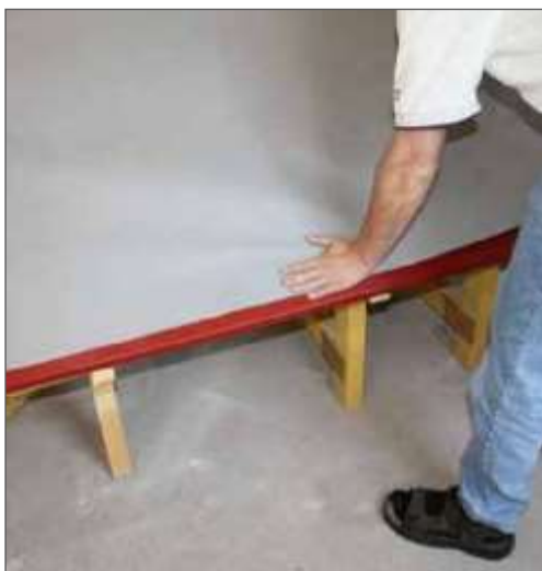
5. Щільно притиснути до стрічки для гарного скріплення
