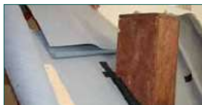
12. Монтировать на планку мембрану внахлест сверху вниз
