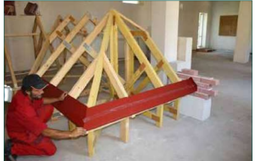
7. Монтувати крапельник по периметру звису
