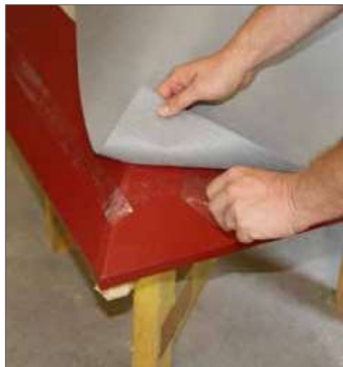
3. Зняти захисну смугу із двосторонньої стрічки
