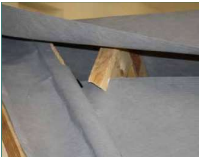
3. Закрепить вырезанный кусок мембраны на конек
