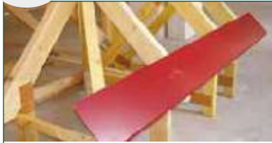
1. Монтувати крапельник
