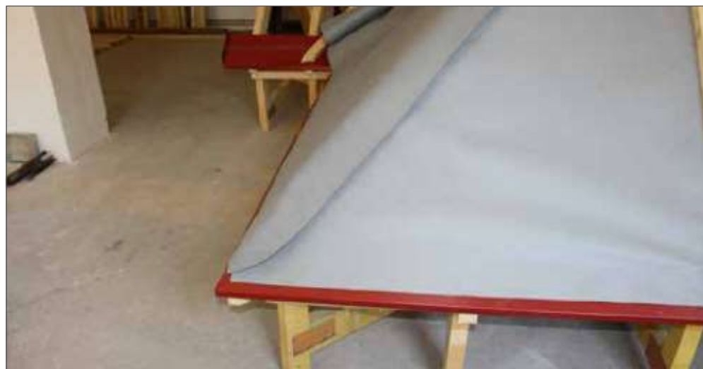
7. Зрізати край мембрани і залишити нахльстування 10 см
