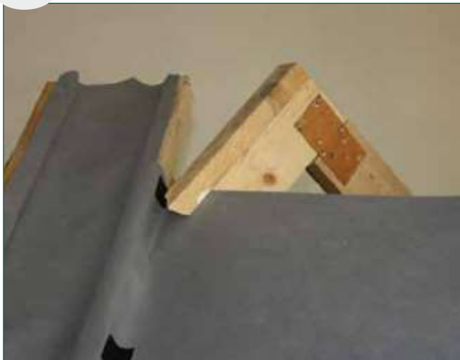
1. Монтировать дополнительные брусья на стропила в области конька
